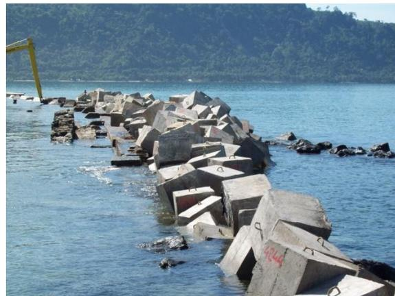
**Gambar 2-7** Breakwater dengan lapisan pelindung menggunakan batu buatan (bton cyclop), Arsip Indonesia Port Corperation (IPC)
