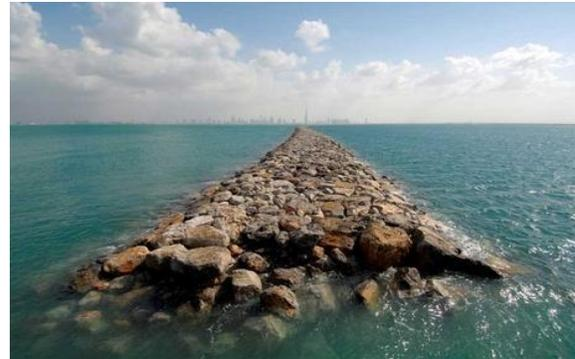
**Gambar 2-6** *Breakwater* dengan lapisan pelindung menggunakan batu alam
